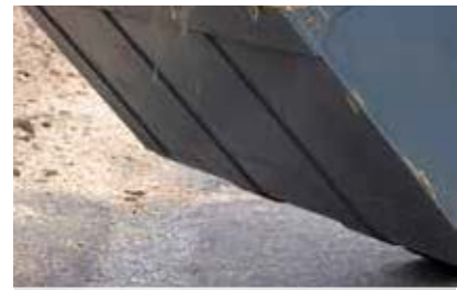
Versteifungsbleche sorgen für einen stabilen Unterbau
