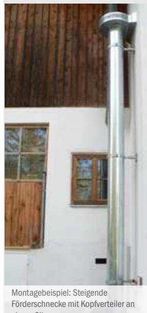
Montagebeispiel: Steigende Förderschnecke mit Kopfverteiler an einem Silo
